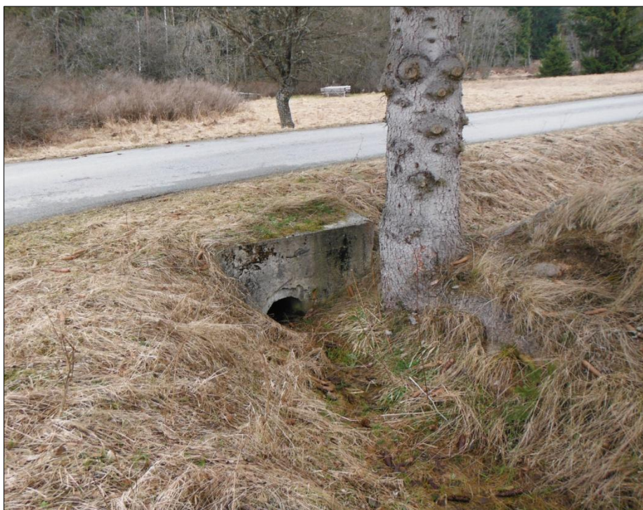
Propustek P17 pod Vltavskou cestou - částečně zanesen.
