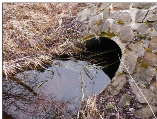
Propustek P21 pod železniční tratí.
